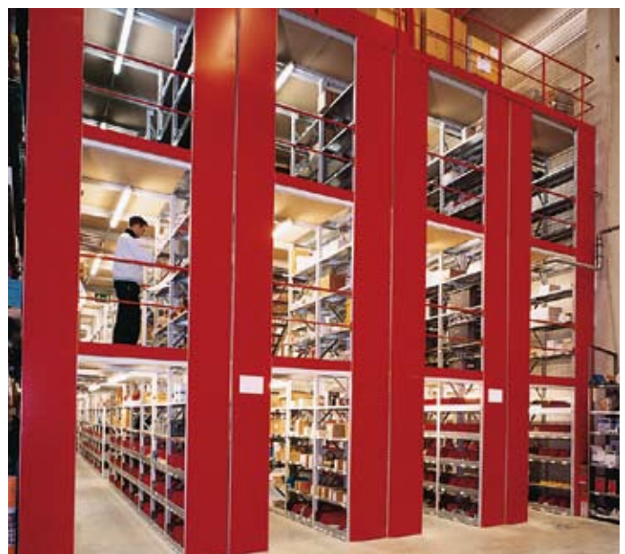
4-geschossige Fachbodenregalanlage mit Lagerbühne, Schutzgeländer, Klapptor und Vollblechstirnwänden.
